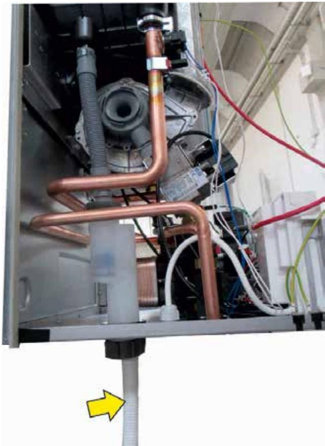
Salida de la condensación: tubo para conectar a la descarga del sistema de alcantarillado
